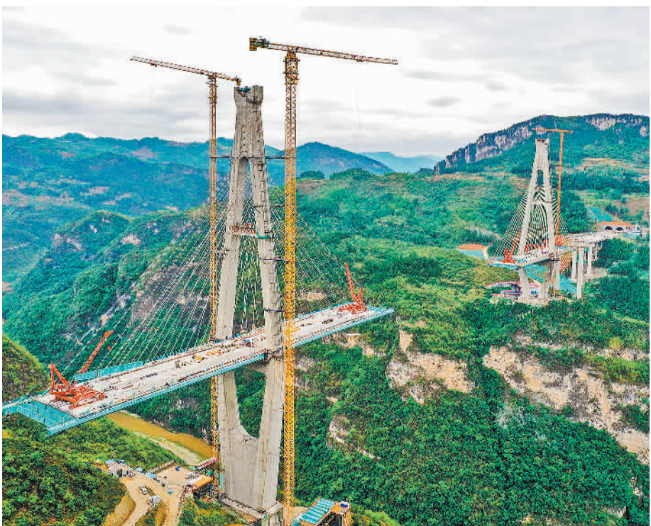
近日，在四川路桥承建的古(简)金(沙)高速赤水河大桥建设项目上，工人们正在加紧施工作业。该桥全长575米，建成后极大促进当地红色资源的有效利用，为中国白酒金三角及川滇黔渝旅游环线提供交通保障。
