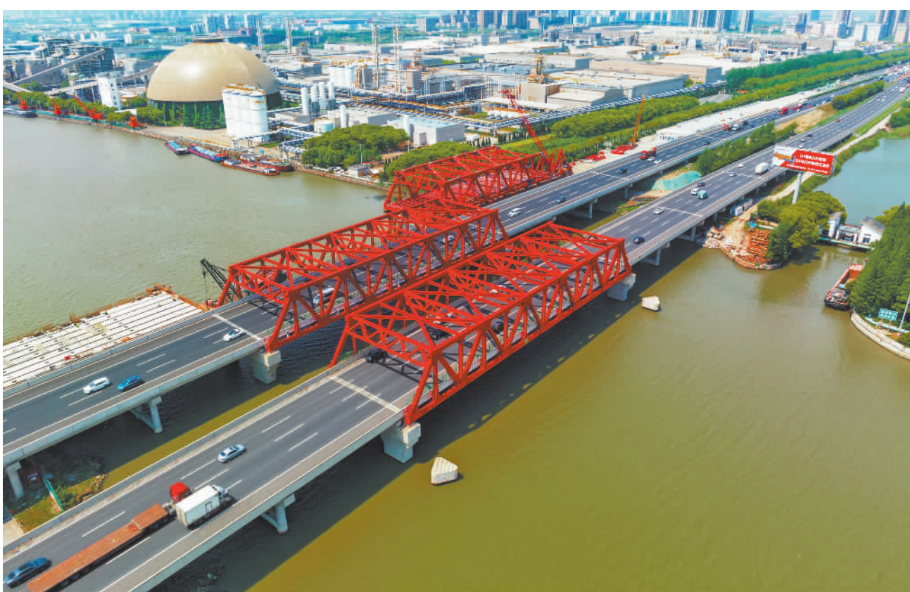
4月27日，江苏省重点工程沪宁高速公路青阳港大桥改造升级工程南半幅正在进行紧张施工，预计今年9月全线通车。届时中张线青阳港段航道将从五级航道提升为三级航道，提升青阳港水运通航能力。张从余摄(中经视觉)
