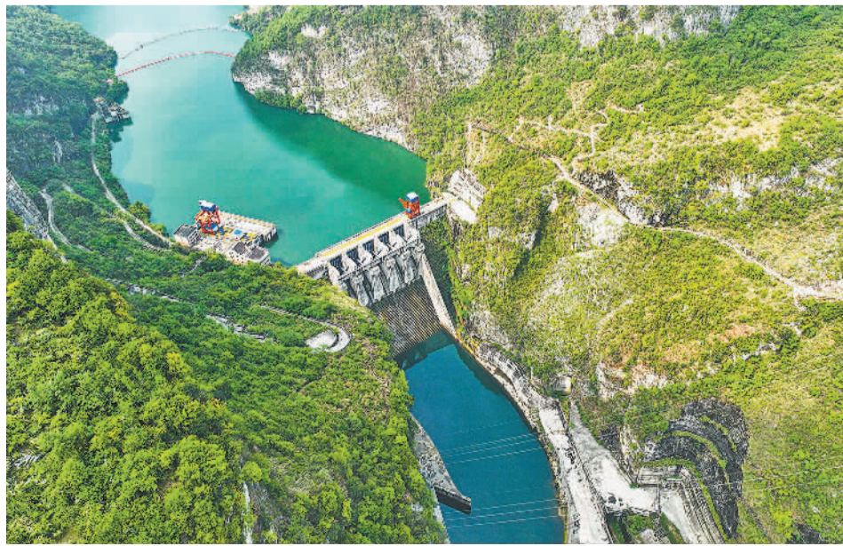
4月22日，航拍贵州省黔西素朴镇境内的乌江索风营水电站。该水电站是贵州“西电东送”首批项目之一，已实现连续安全运行近18年。周训超摄(中经视觉)
