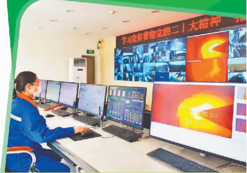
祁連山水泥工作人員在水泥窯中控室操作和監控生產。
