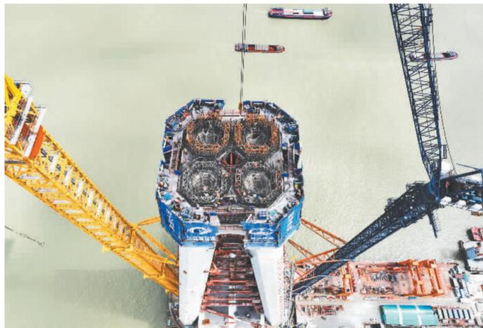
4月13日，由中铁大桥局承建的常泰长江大桥6号主塔的中塔柱完成4个塔肢的合龙工作。该大桥拥有目前世界在建最高塔塔，建成后连接江苏常州与泰州，是长江首座集高速公路、城际铁路、一级公路于一体的过江通道。 陈 晔摄(中经视觉)
