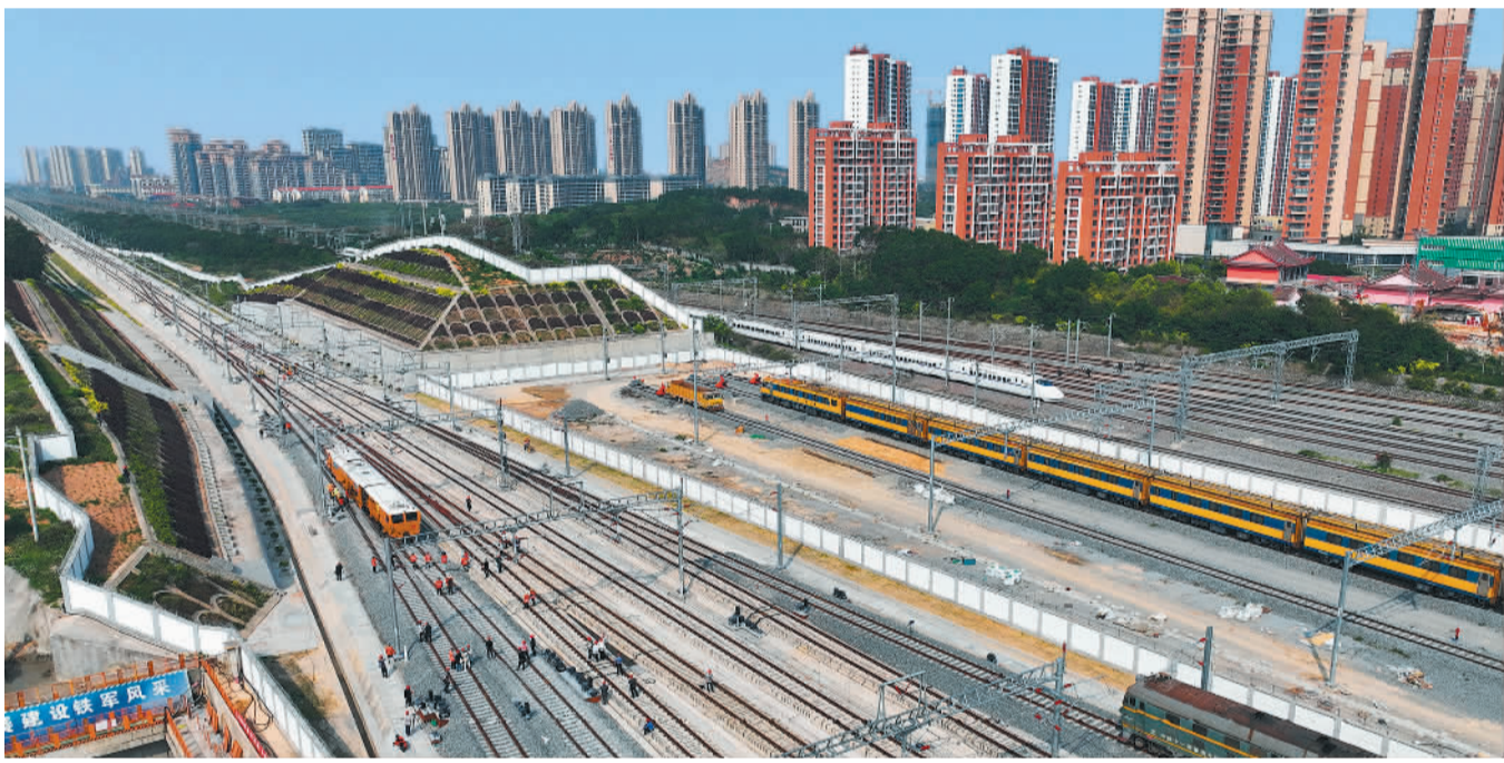
4月11日，在福厦高铁莆田站新建站场，作业人员与大型养路机械共同配合，对最后900米有砟轨道精细调整结束，标志着福厦高铁全线轨道精调顺利完成，为下一步全线联调联试工作打下坚实基础。新华社记者 林善摄
