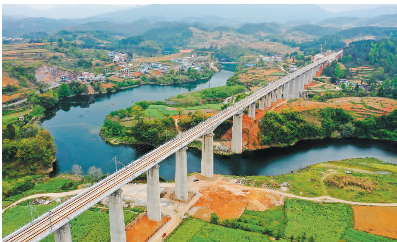
4月9日拍摄的贵南高铁(贵州段三标)营盘清水河双线特大桥。目前,贵(阳)南(宁)高铁建设进入冲刺阶段,为年内通车奠定基础。贵南高铁设计时速350公里,是我国“八纵八横”高速铁路网包头至海口通道的重要组成部分。肖伟摄(中经视觉)
