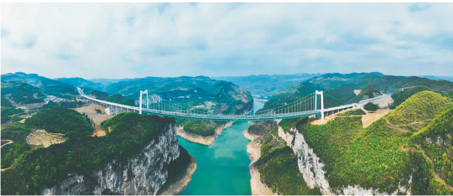
4月4日,贵州金烽乌江大桥完成桥面铺装施工,具备通车条件。该桥位于贵州省金沙县与息烽县交界处的乌江之上,是贵(阳)金(沙)高速的重点控制性工程。贵金高速建成后,将对完善黔中经济区的路网结构、提升贵阳至成渝经济区通道运输能力具有重要意义。张 鹏摄(中经视觉)
