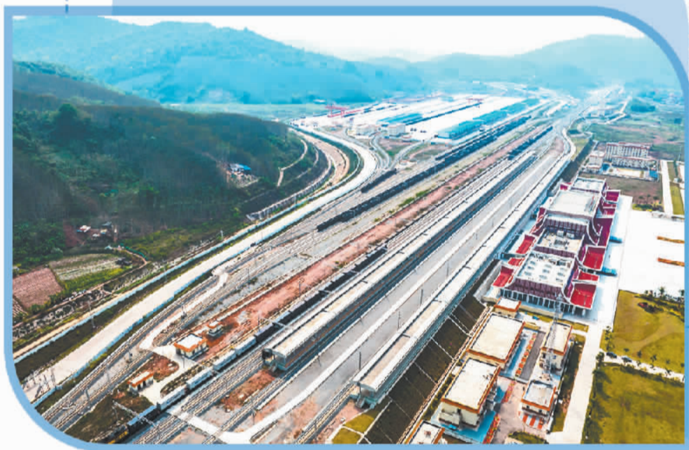
下图 2月22日拍摄的中老铁路磨憨站(无人机照片)。新华社记者 江文耀 摄
