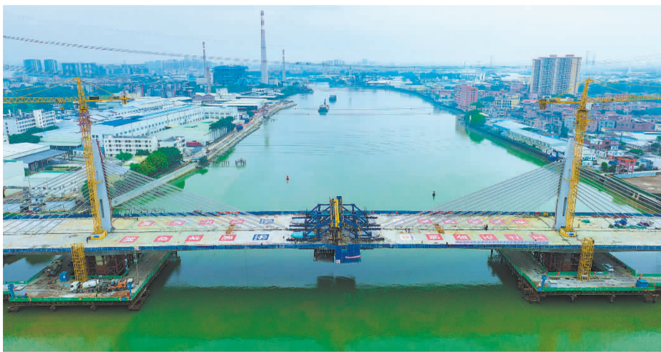
4月2日,广东省东莞市中洪路项目榉马特大桥中跨合龙段顺利完成浇筑,标志着榉马特大桥主跨成功合龙,为项目建成通车奠定坚实基础。榉马特大桥全长686.5米,是东莞市首座矮塔斜拉桥。 卢建建摄(中经视觉)
