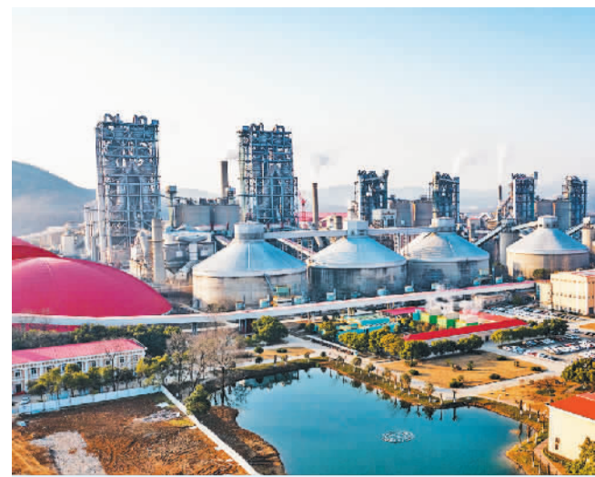
安徽海螺集团大力开展节能减排,争创国家级绿色矿山,努力打造现代化绿色工厂。图为芜湖海螺水泥有限公司生产厂区。 肖本祥摄(中经视觉)
