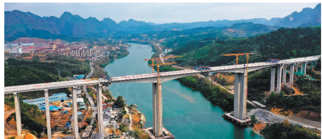
3月24日,广西最大跨径6车道连续刚构桥——天巴高速红水河特大桥实现双幅合龙。天巴高速为天峨至北海公路重要路段,建成后将有效改善区域交通条件。高东风摄(中经视觉)
