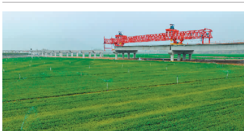
3月22日，建设中的济新高速河南济源五龙口段沁河特大桥。大桥建成后，将加强济源、洛阳与西北区域的交通联系，有效带动当地经济社会发展。 常志东摄(中经视觉)
