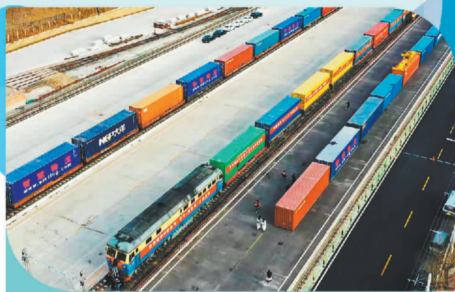
3月16日，在北京平谷地方铁路马坊站，京平综合物流枢纽中欧班列(北京—莫斯科)停靠在站台(无人机照片)。 (新华社发)
