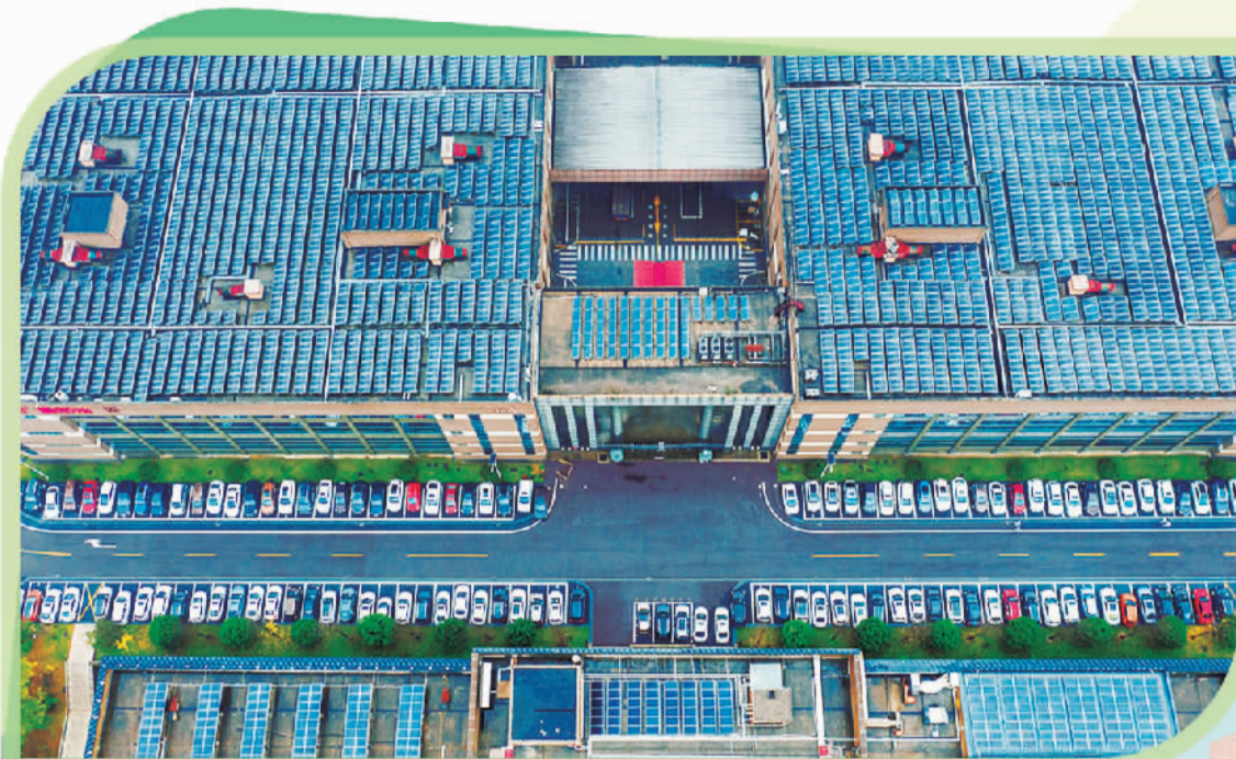
杭州市临安区金马工业园区内的一家“无废工厂”,屋顶上安装了光伏发电设备。近年来,当地积极推进辖区企业升级改造,深化固体废物综合利用,助力“无废城市”创建。 新华社记者 徐 昱摄
