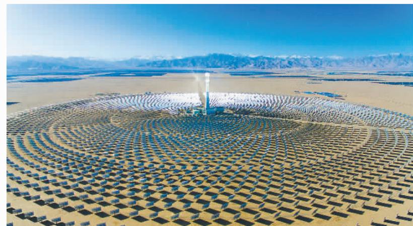
青海海西多能互补国家示范工程
