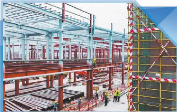
右图 天丝集团红牛饮料(四川)生产基地项目施工现场。 下图 位于上海张江的施耐德电气关键电源创新实验室。
