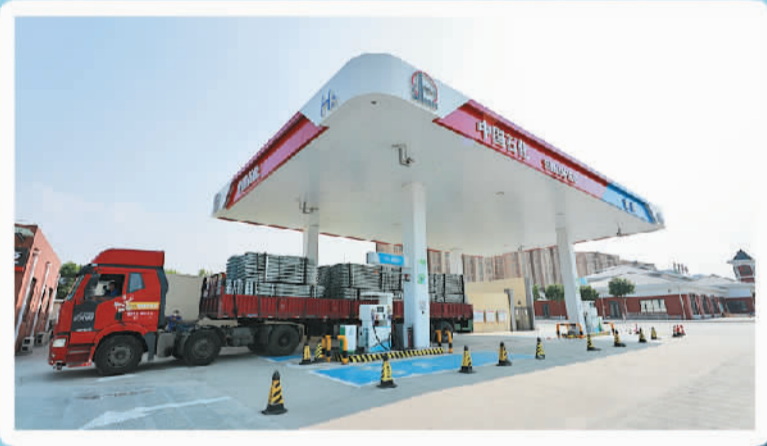
全国率先建立的高速公路服务区加氢站
