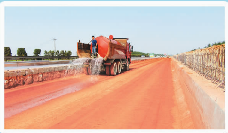
将赤泥转化为优质筑路材料,解决赤泥大规模利用的世界技术难题
