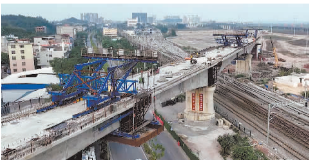
2月21日，中铁十六局集团参建的广西防城港市至东兴市铁路西湾跨海双线特大桥转体连续梁顺利合龙。防东铁路开通后，两地运输时间将缩短至20分钟。李绍华摄（中经视觉）
