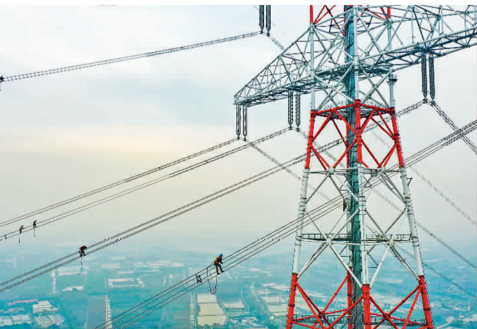
2月20日，在385米世界最高输电铁塔——江苏凤城至梅里500千伏输电线路工程长江大跨越现场，施工人员正在百米高空进行走线验收。该工程建成投运后，可满足约800万户家庭的日常用电需求。 史俊摄(中经视觉)
