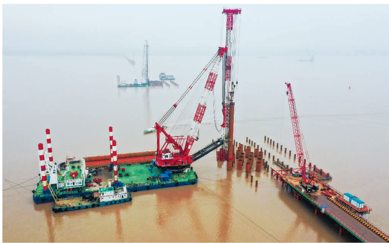
2月18日拍摄的崇启公铁长江大桥永久钢护筒施打作业现场。近日，由中铁大桥局承建的崇启公铁长江大桥在长江北岸江苏启东一侧江面开始进行永久钢护筒施打作业，正式拉开大桥主体全线开工建设的序幕。崇启公铁长江大桥是沪渝蓉高速铁路全线重点控制性工程，大桥全长4.09公里，是江苏启东与上海崇明的主要连接通道。新华社记者 李博摄
