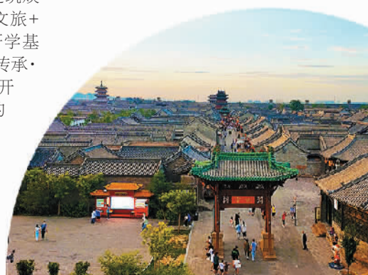
在修缮时尽量保证“原汁原味”的古县城建筑群。
