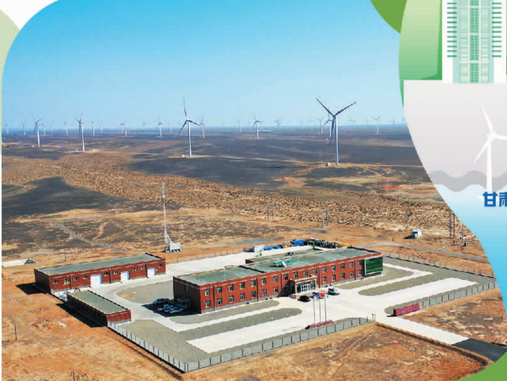
图为甘肃省酒泉市境内的风电基地。
