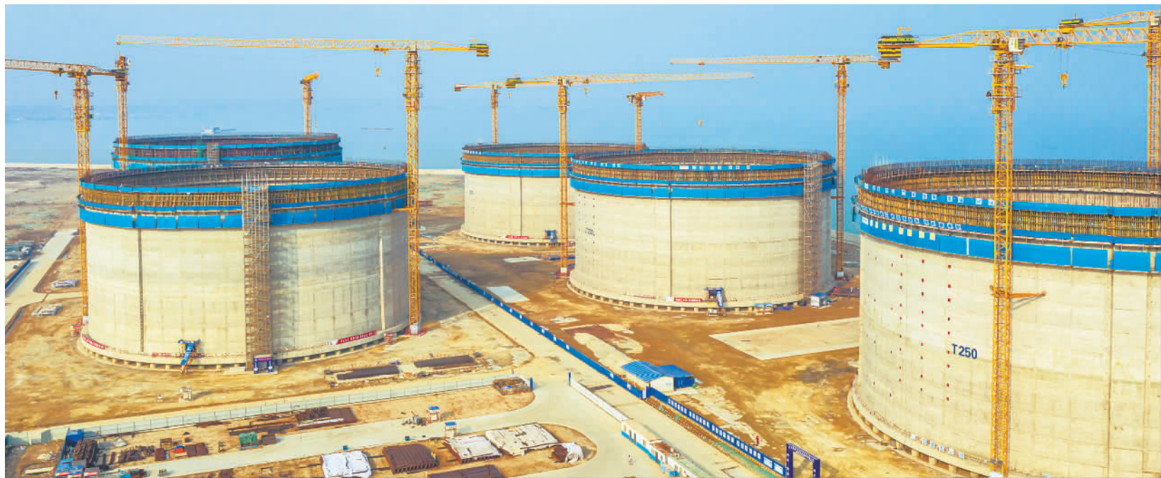
2月6日，山东烟台港西港LNG接收站项目现场，5座20万立方米储罐正在施工建设。该项目计划年底投产，可持续稳定地为山东、环渤海乃至华北地区提供能源保障，增强区域调峰、储气和冬季保供能力。张超摄(中经视觉)
