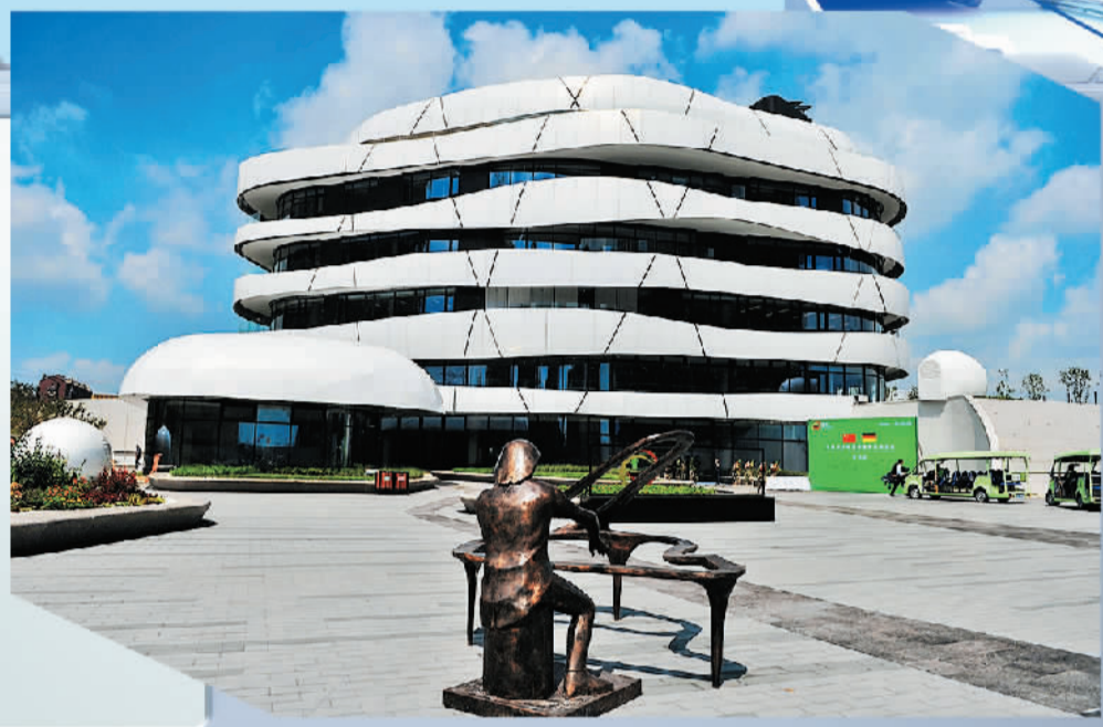
中德生态园是青岛工业园区低碳转型改革的探路者。图为中德生态园驱动房技术体验中心。
