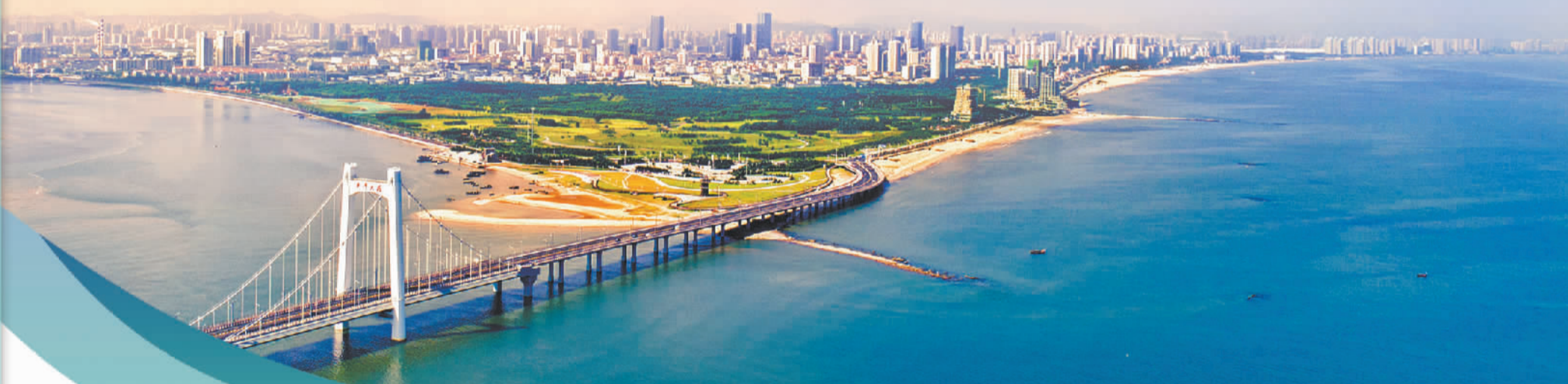
烟台黄渤海新区高标准推进岸线修复和保护。姜蕊摄(中经视觉)
