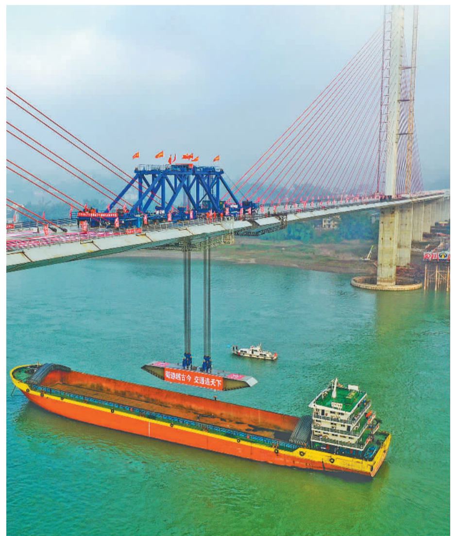
1月9日，随着最后一块钢箱梁吊装完成，四川省泸州市白沙长江大桥实现全面贯通。该桥是合江新城过江通道工程，是世界第一大跨径双塔独柱中央平行索面斜拉桥，预计今年5月建成通车，将助力完善区域交通网络。李贵平摄（中经视觉）
