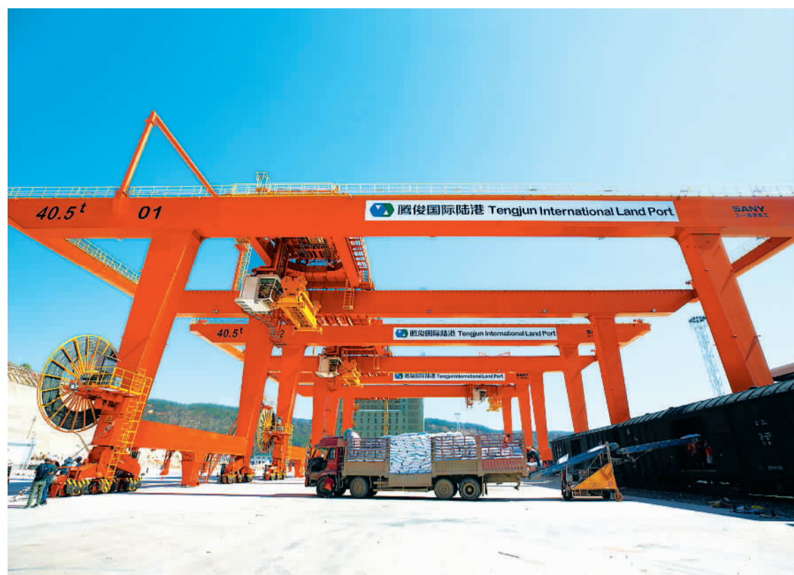
昆明腾俊国际陆港公铁多式联运物流中心。 (资料图片)
