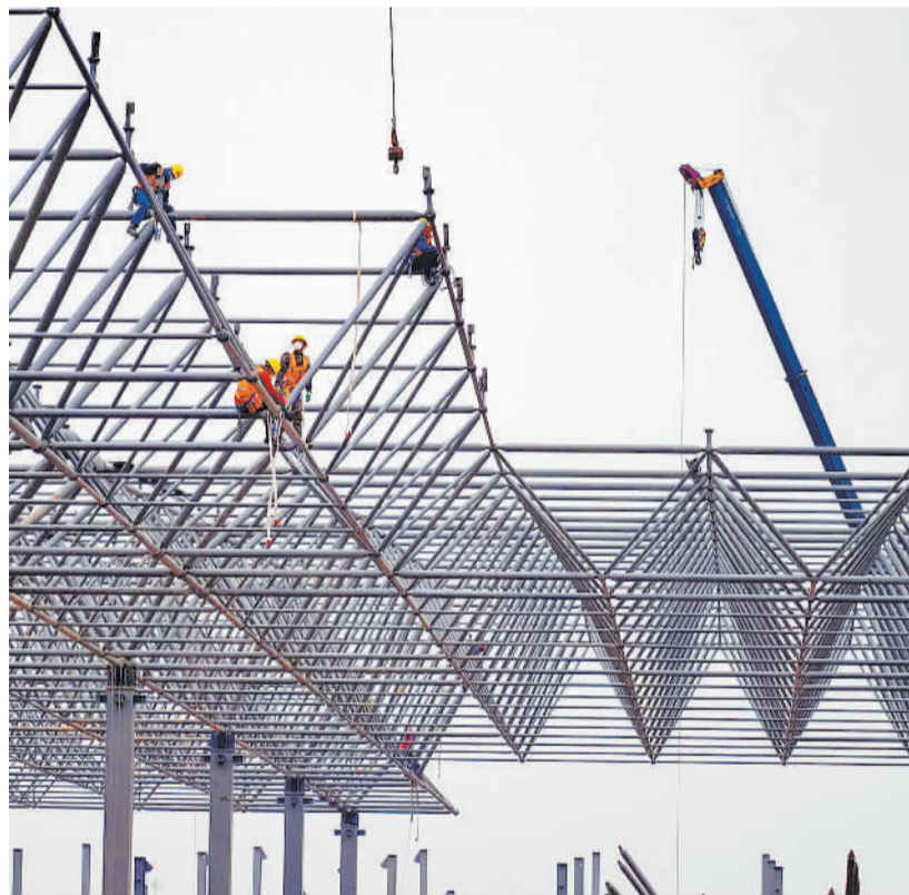
12月27日，位于浙江省金华市金义新区的新能源汽车零部件产业园项目施工现场，员工正在搭建厂房。该项目总投资100亿元，计划于2024年投产。近年来，金义新区抢抓长三角一体化发展等重大战略机遇，全力推动一批重点项目落地。朱 聿摄（中经视觉）
