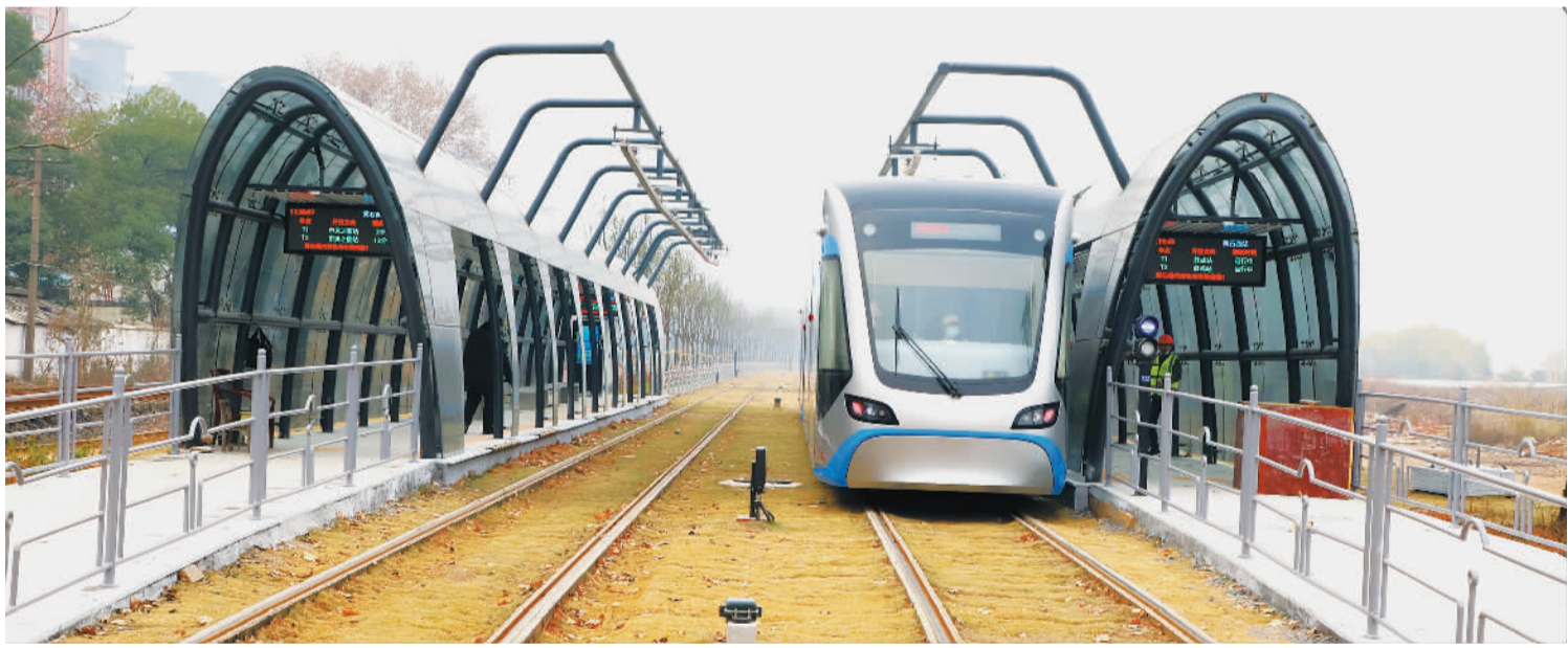
12月28日,由中铁十六局等参与建设的湖北省首条地级市有轨电车——黄石现代有轨电车一期工程建成通车。该项目线路全长26.88公里,有助于缓解沿线交通压力,改善市民出行环境,构建城市立体交通走廊,推动老工业城市焕发新活力。许鹤摄(中经视觉)
