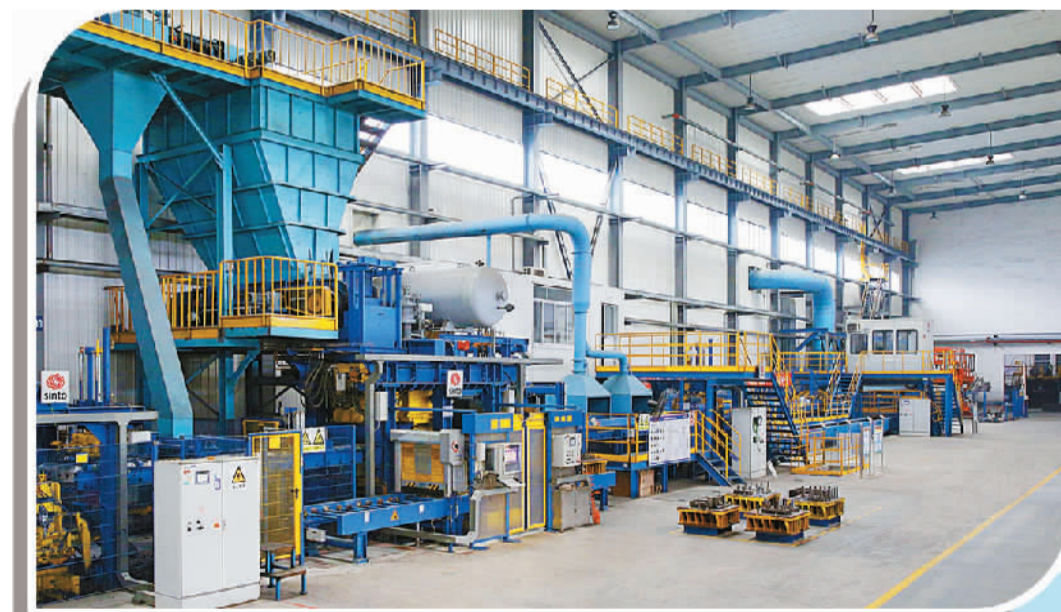
柳工柳州铸造有限公司潮模砂HWS(静压造型线)全自动浇注生产线。(资料图片)
