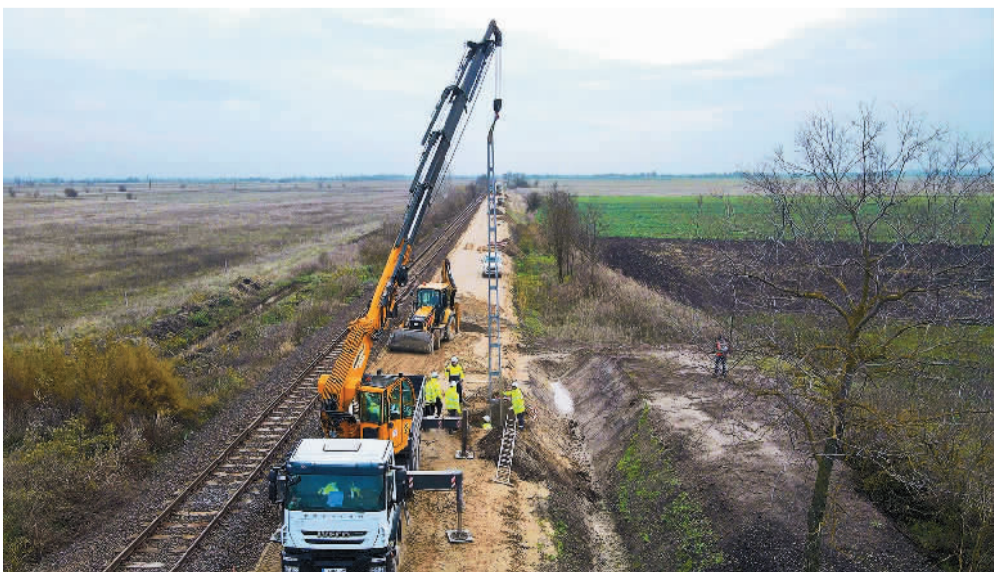
图为匈塞铁路匈牙利段施工现场。
