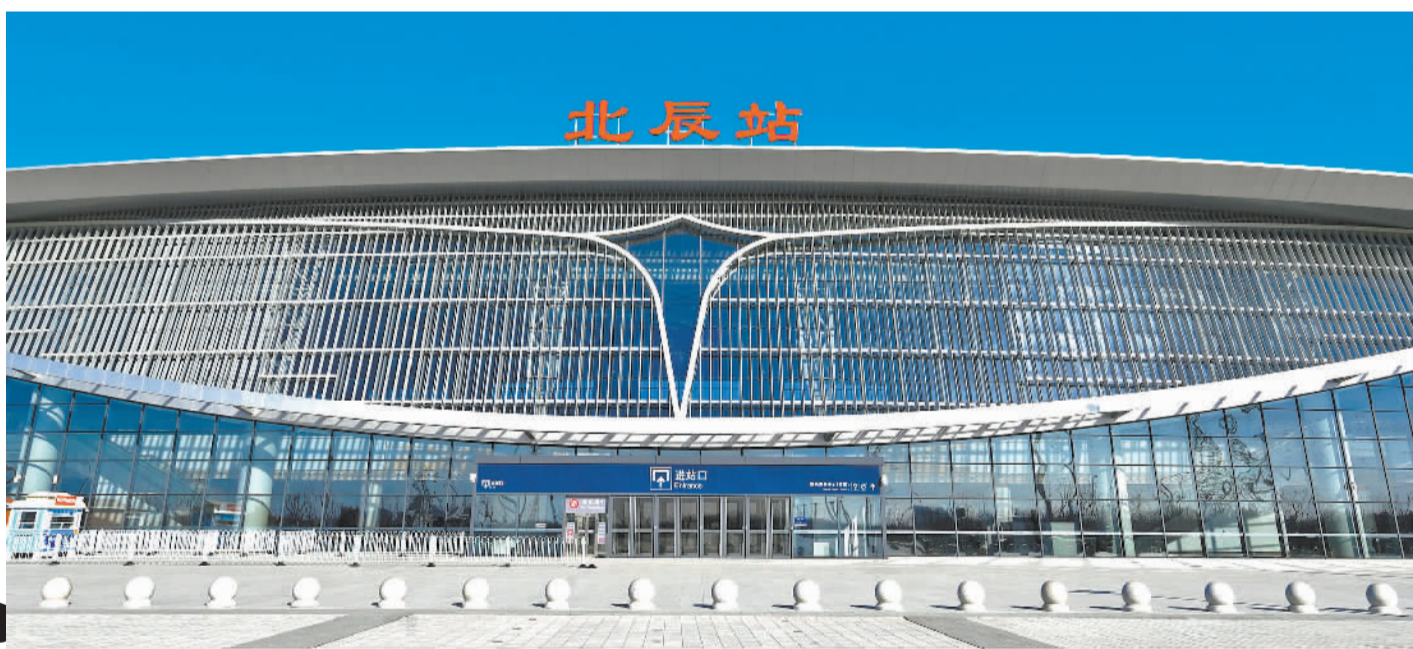
12月17日，即将投入使用的京滨城际铁路北辰站站房外观。目前，京滨城际铁路开通在即，已经进入了试运行阶段。京滨城际铁路全线建成通车后，从北京直达天津滨海新区仅需57分钟，将有力助推京津冀协同发展。孙立君摄(中经视觉)
