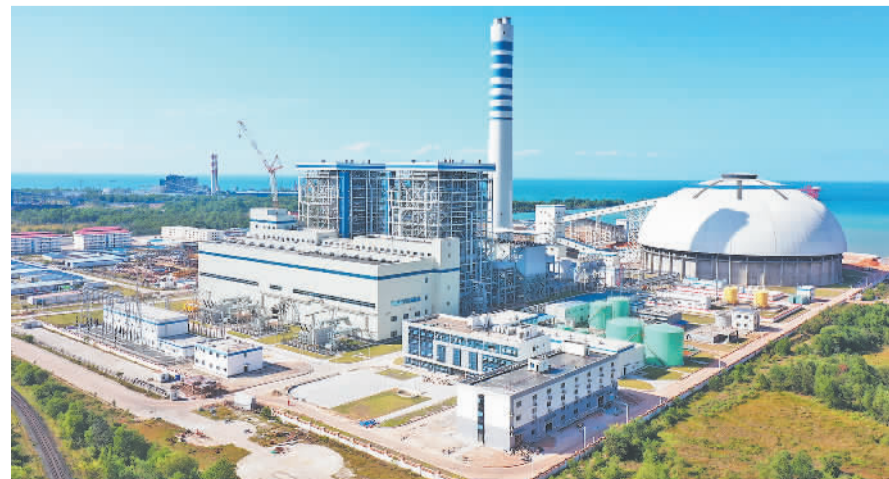
图为柬埔寨西哈努克港燃煤电站。
