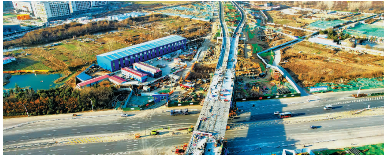
近日，中铁十六局集团承建的江苏徐州市彭祖大道快速路跨汉源大道钢混连续梁顺利合龙。该道路建成将缓解交通压力，便利市民出行。张媛媛摄（中经视觉）
