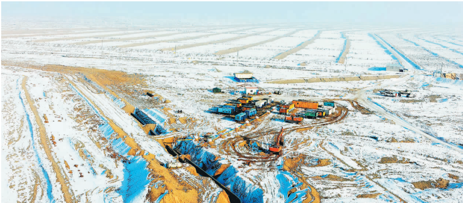
12月17日，新疆阿克苏地区拜城县，塔里木油田博孜1集气站至大北处理站天然气管道一次性投产成功。该管道日输气量可达500万立方米，为冬季天然气管道再添“底气”。 谭 辉摄 (中经视觉)
