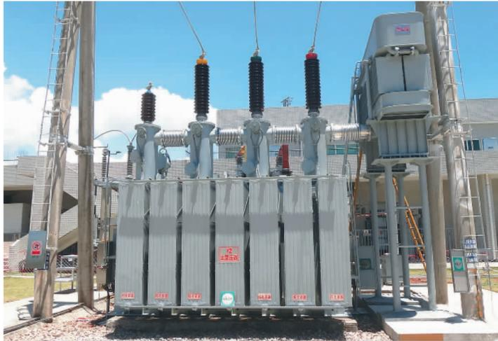
深圳大鹏变电站使用的110千伏、容量5万千瓦安液浸式不燃电力变压器。(资料图片)
