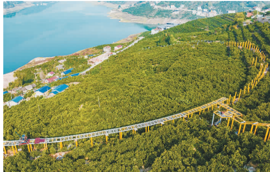
12月12日，工人在湖北省宜昌市秭归县归州镇彭家坡村乡村振兴示范区项目工地施工。该县充分利用自然资源优势，建设脐橙精品果园和脐橙文化全方位体验平台，推进现代脐橙产业发展，助力乡村振兴。 郝家裕摄(中经视觉)
