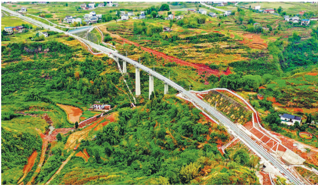
12月13日拍摄的重庆市万盛经开区关坝铁路专用线项目建设现场。
