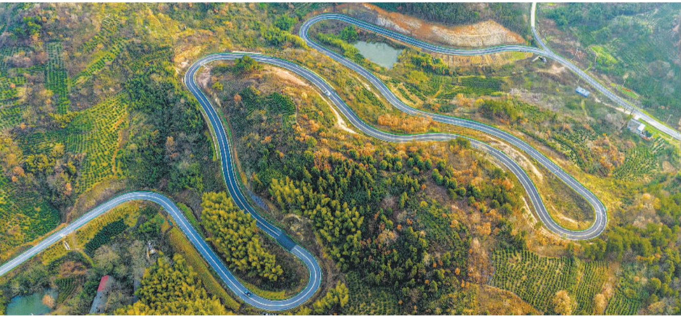
12月11日航拍的安徽省合肥市庐江县汤池镇百花村盘山公路，犹如一条彩带缠绕在绿树青山之中。近年来，庐江县持续推进“四好农村路”建设，全县建立农村公路三级“路长制”。截至目前，全县农村道路已实现“村组通”。左学长摄(中经视觉)
