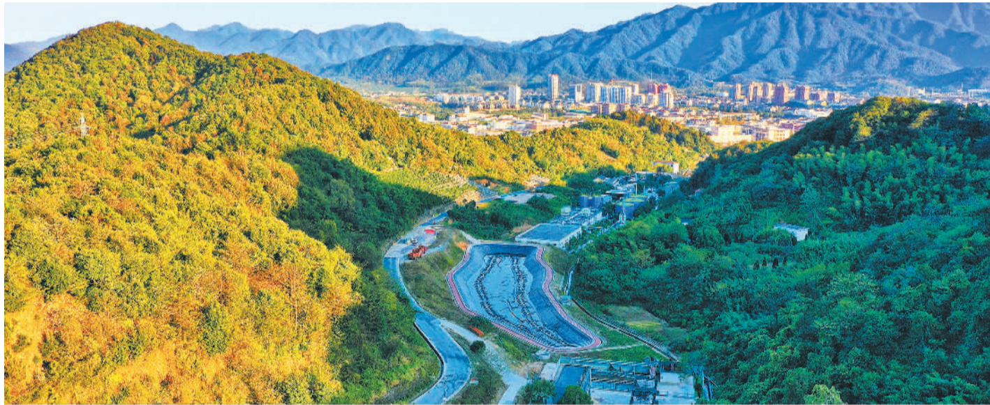
11月28日，俯瞰浙江省绍兴市大坞岙垃圾填埋场生态修复工程现场，12万平方米的花草绿地绵延整个山岙。该工程通过实施地下水污染控制、景观绿化、库区整形等多项治理措施，成功使昔日脏乱的“垃圾山”变为青山含翠的“后花园”。何 雯摄(中经视觉)
