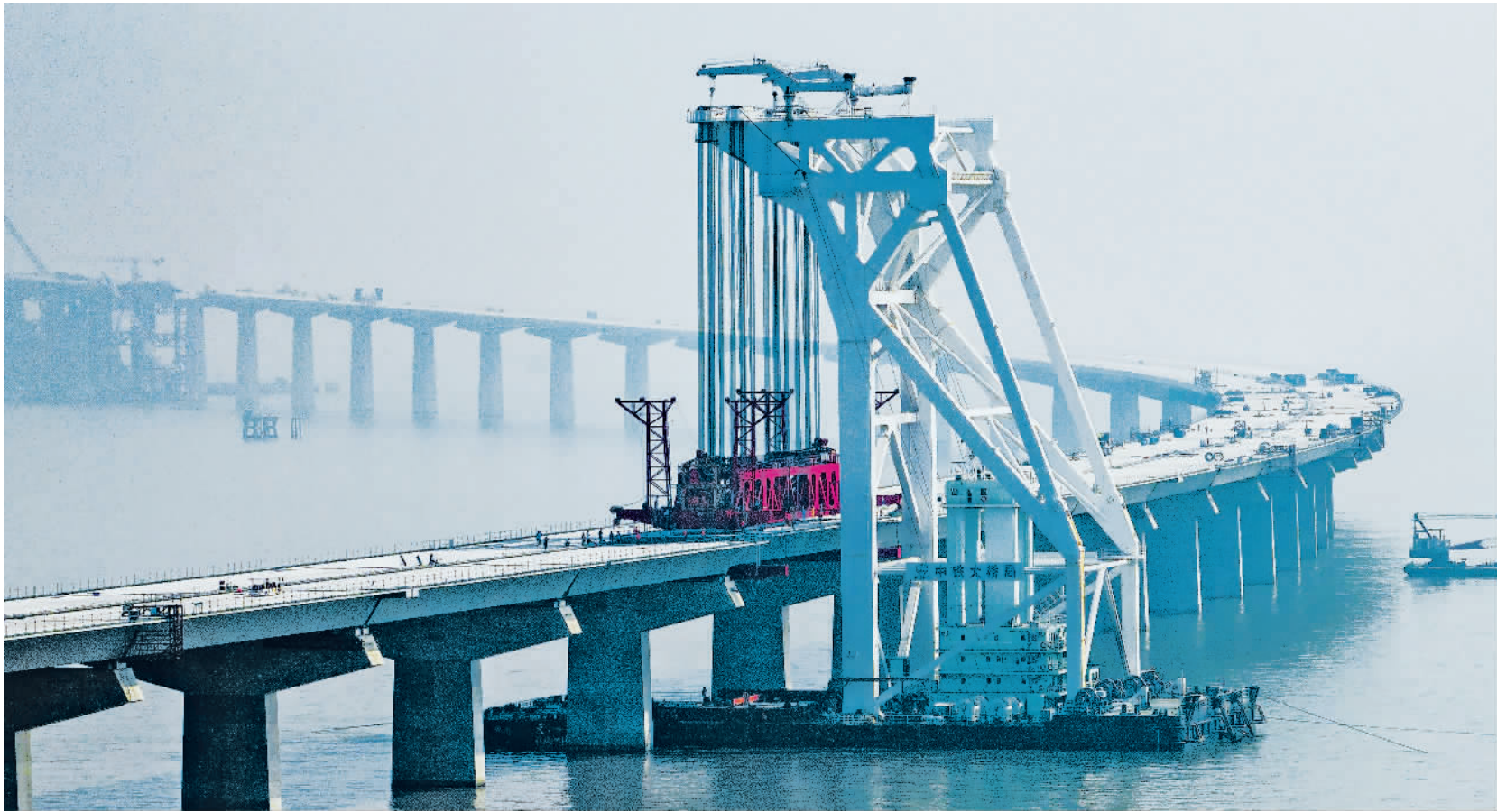
11月10日,起重船将深中通道海上非通航孔桥最后一块混凝土箱梁架设至指定桥墩(无人机照片)。当日,深中通道海上非通航孔桥混凝土箱梁全部架设完成。深中通道是“桥、岛、隧、水下互通”于一体的跨海集群工程,全长约24公里,其中桥梁工程长约17公里。 陈正东摄(新华社发)
