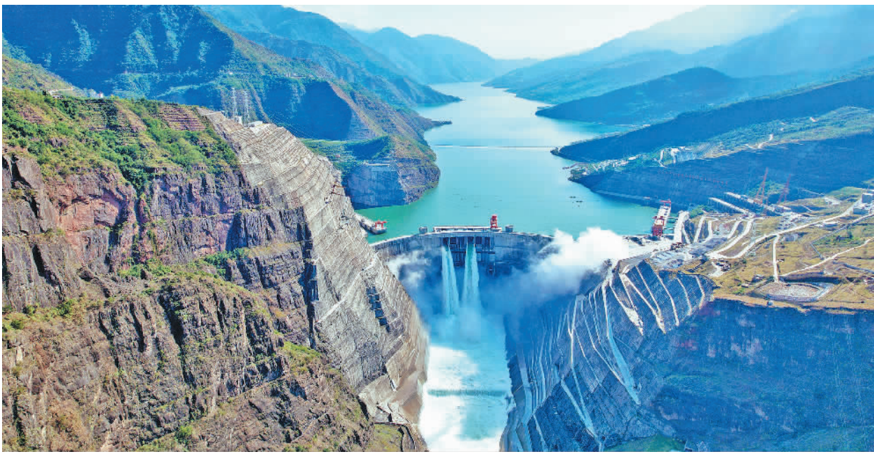
11月5日,白鹤滩水电站10号机组顺利通过72小时试运行,正式投入商业运行,标志着白鹤滩水电站进入全面投产发电最后冲刺阶段。白鹤滩水电站总装机容量1600万千瓦,是我国实施“西电东送”的国家重大工程。 闫科任摄(新华社发)
