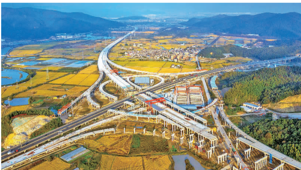
10月29日，建设中的浙江省宁波市象山湾疏港高速塘溪枢纽。作为宁波舟山港集疏运网络的重要通道，该项目建成后，将完善区域高速网布局，降低企业物流成本。 胡学军摄（中经视觉）
