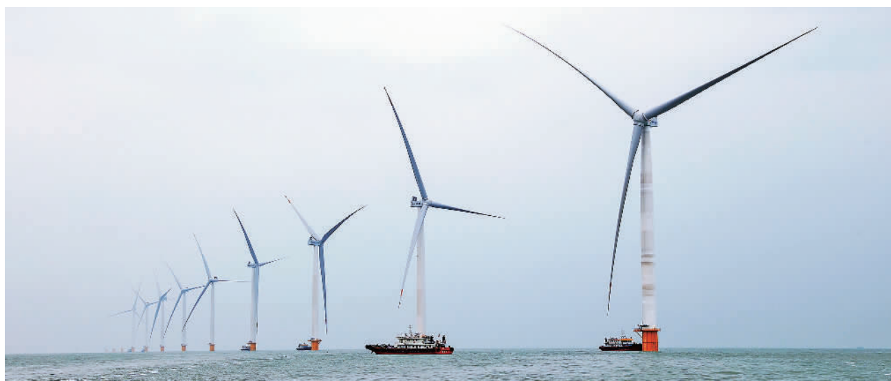
10月29日,渤海海上风电A场址项目现场,调试船正对风力发电机进行调试。当日,该项目首批机组顺利并网,发出了海上风电平价时代全国首个核准项目第一度绿电。该项目位于距离山东省东营港20公里的渤海中部近海海域,总投资66.85亿元,每年可提供绿色电量16.98亿千瓦时。
