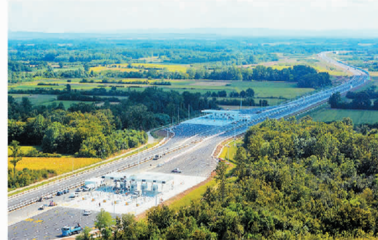
山东高速集团承建塞尔维亚E763高速公路,是中资企业率先在欧洲建成通车的高速公路
