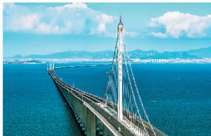
山东高速集团率先投资建设我国北方冰冻海域特大型桥梁集群工程——青岛胶州湾大桥
