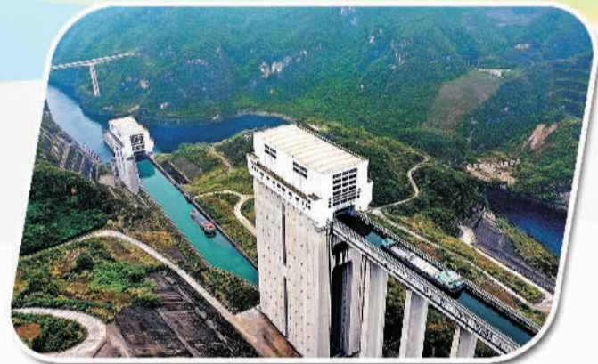
2021年11月,构皮滩水电站通航设施正式投用,升船机最大提升高度达127米,中断近20年的贵州乌江水运大规模全线复航。图为运载着磷矿石的货船在构皮滩通航处通过
