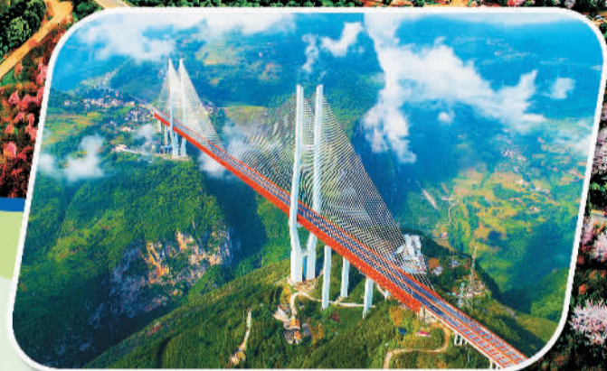
“天下高桥半在黔中”。世界高桥前100名中有49座、前10名中有4座在贵州省。图为桥面至水面高差565米的世界高桥——杭瑞高速公路北盘江大桥
