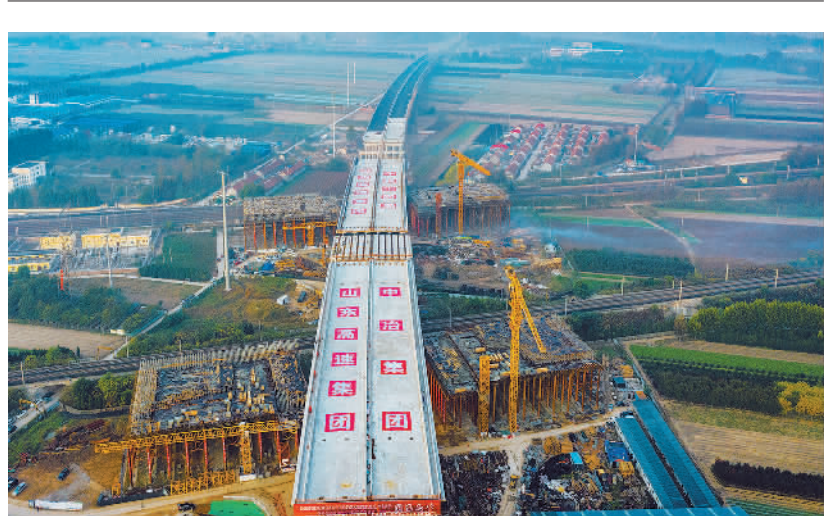
10月13日,由山东高速集团投资建设的潍坊至青岛公路及连接线工程(潍青项目)跨胶济客运专线、胶济铁路两个T型连续刚构特大桥完成空中精准对接,为年底前潍青高速中线建成通车奠定坚实基础。 张明摄(中经视觉)
