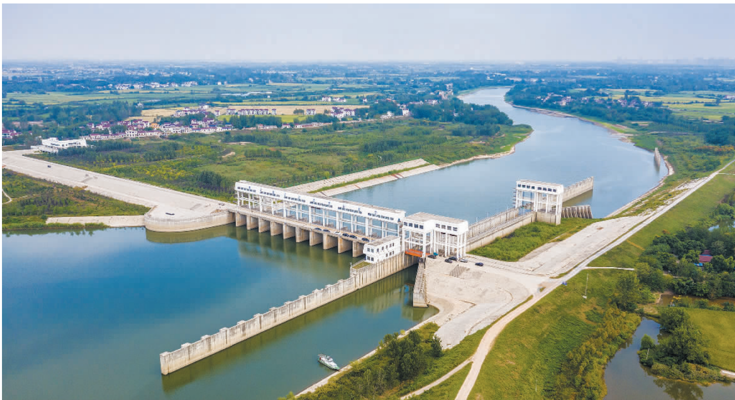
9月23日,航拍位于安徽省芜湖市湾沚区红杨镇境内的青弋江分洪道红庙节制闸枢纽工程。
