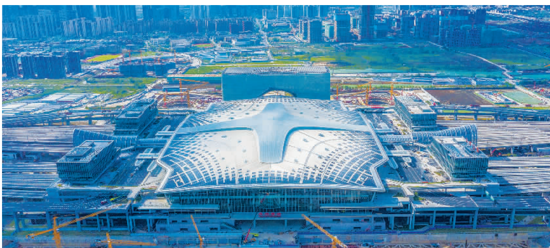
9月22日,由中国中铁建工集团承建的杭州西站正式投运。作为“轨道上的长三角”重要节点和杭州亚运会重要交通保障工程,杭州西站是合杭高铁湖杭段最大的新建车站,总建筑面积约51万平方米。杨策弘摄(中经视觉)
